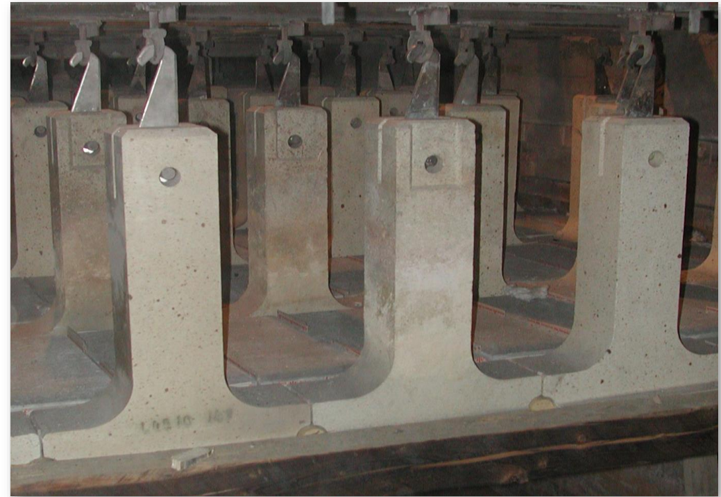
Abbildung der Hängedeckensteinkonstruktion (Hängersteine und Zwischendeckensteine)
