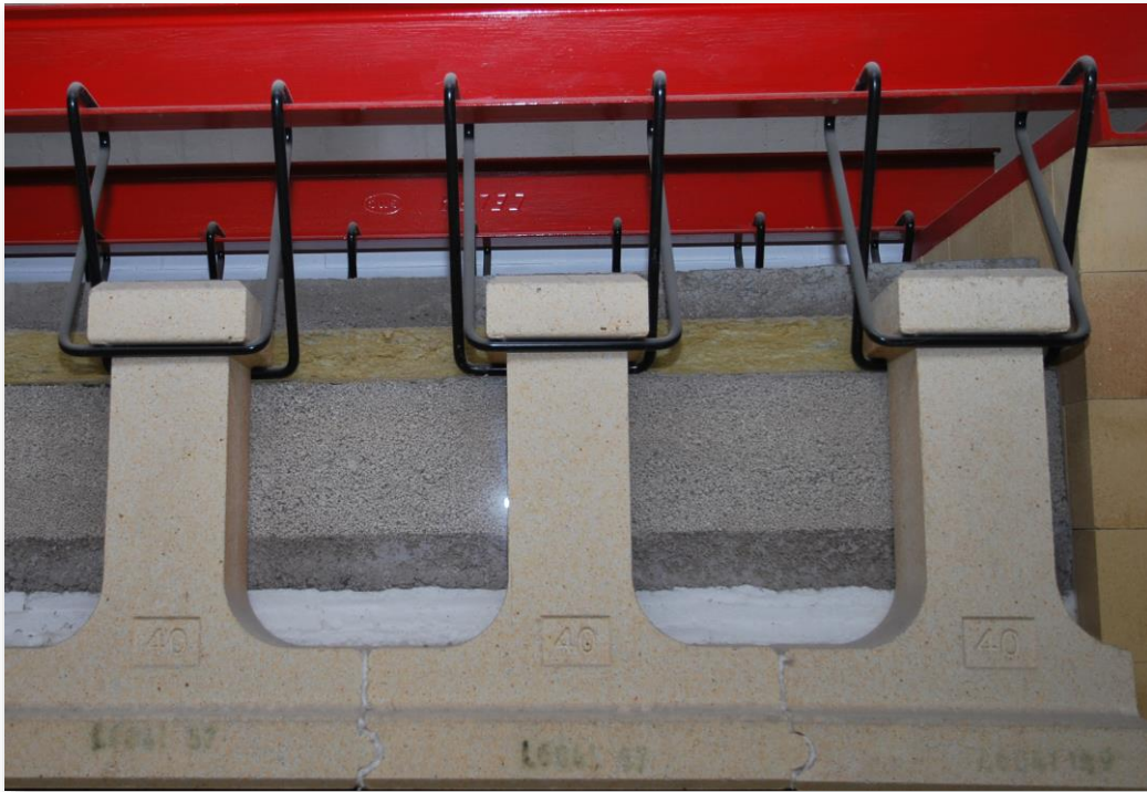
Abbildung einer Musterdecke mit mehrschichtiger Hinterisolierung
